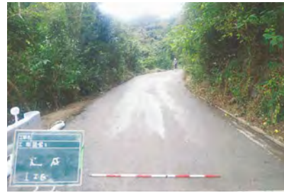
林道の舗装整備
